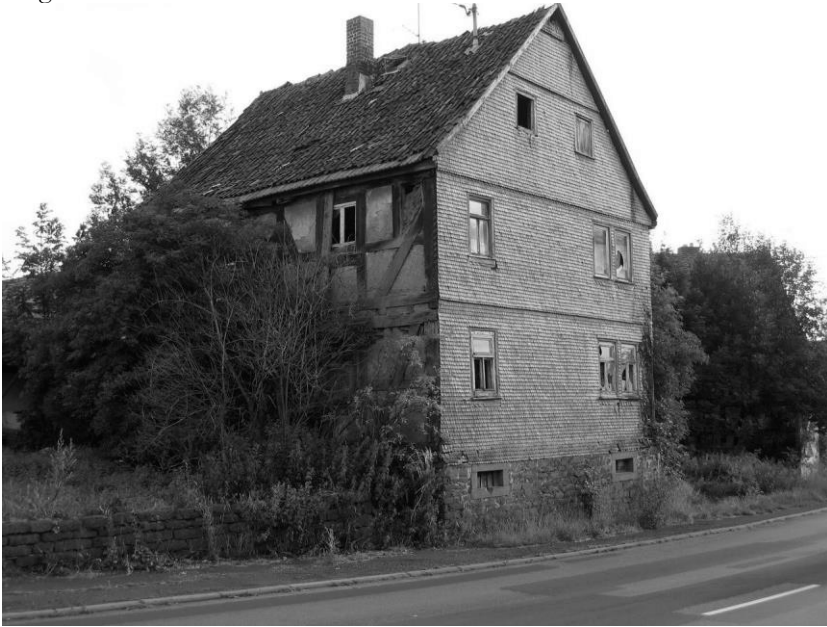
Abb. 1: Das ehemalige Wohnhaus der Familie Speier, retrospektiv das „Ghettohaus“, von dem aus am 07.09.1942 die letzten in Angenrod verbliebenen Israeliten deportiert wurden. (Aufnahme aus dem Jahr 2012) Foto: Ingfried Stahl
