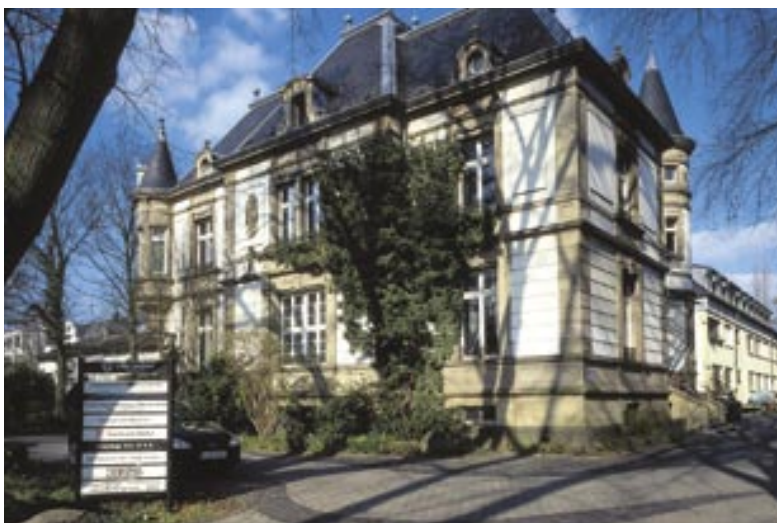
In der historischen Villa Leutert hat das Transferzentrum Mittelhessen (TzM) seinen Sitz, das gemeinsame Büro für den Wissens- und Technologietransfer der Universitäten Gießen und Marburg sowie der Fachhochschule Gießen-Friedberg
