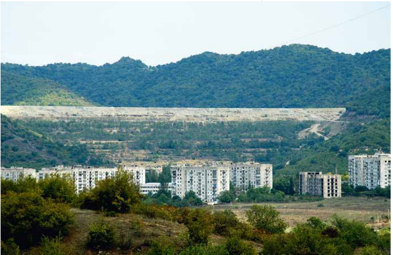
■ Abb. 3: In einer Fabrik der Ortschaft Kazreti werden die Erzpartikel vom Gestein durch Flotation getrennt. Die durch sukzessive Aufschüttung entstandenen Dammgenerationen eines riesigen Beckens für Flotationsrückstände, das sich oberhalb eines Wohngebietes befindet, werden nur spärlich von Vegetation bewachsen und unterliegen der Erosion. Das Erosionsmaterial wird in den Mashavera gespült.
