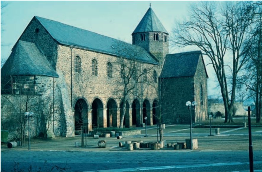
Abb. 13: Basilika und Innenhof nach der Sanierung, 1977 (Foto: Manfred Blechschmidt).
