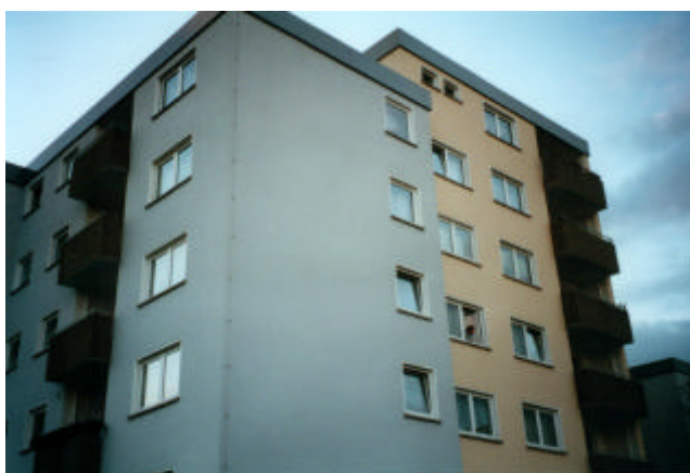
Abb. 9: Sanierte Schlichtbauwohnungen - Gießener Weststadt
