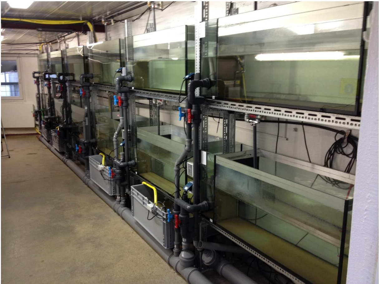
Abbildung 10: Teilansicht der Haupt-Versuchsanlage für Fütterungsversuche 1 bis 3; graue Kunststoffkästen unten sind Pumpensümpfe.
