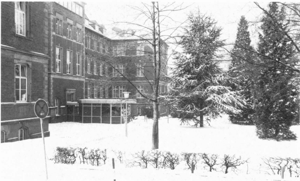
Abb. 29,1: Teilansicht der Frauenklinik – Mitteltrakt und Pforte – mit Vorgarten und Direktorhaus im Hintergrund
