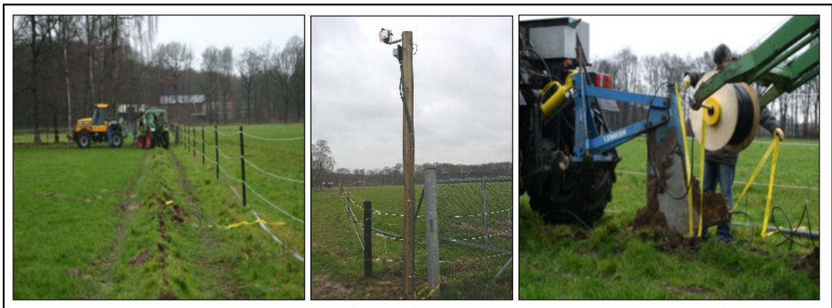
Abbildung 99: Für den Aufbau der Funkortungsanlage mussten aufwendig Masten errichtet und Erdkabel verlegt werden, wofür spezielle Geräte notwendig waren.
