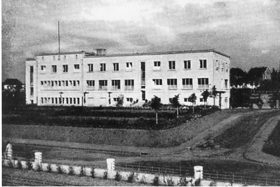
Abb. 43 Behandlungsbau von vorne 1931
