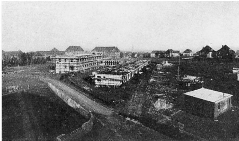
Abb. 41 e Baustelle Orthopädische Klinik. Gesamtansicht am 25. November 1930
