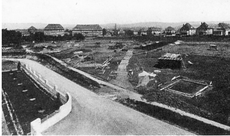
Abb. 41 a Baustelle Orthopädische Klinik. Am 28. August 1930. Blick von der Heilstätte Seltersberg
