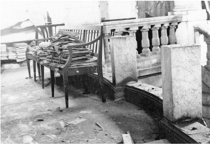
Das zerstörte Treppenhaus der Universitätsbibliothek
