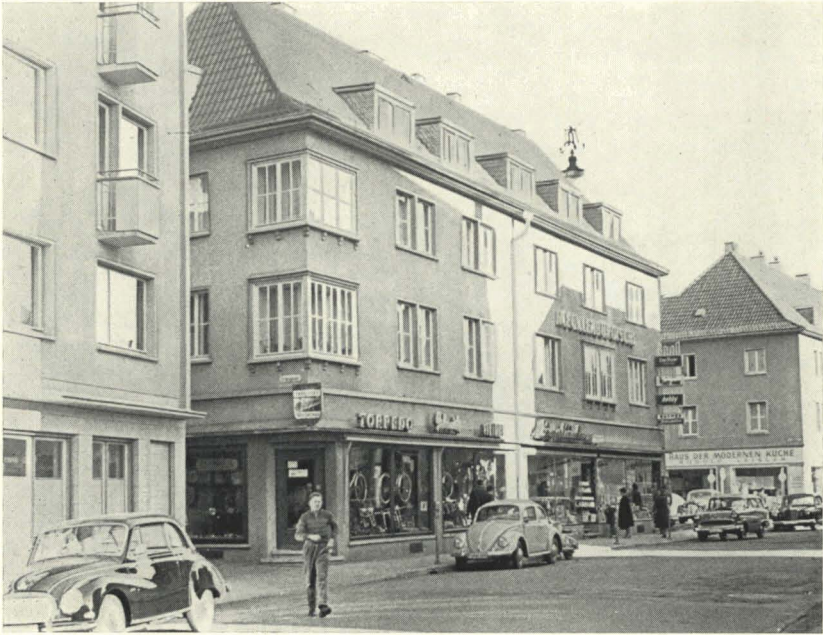
Blick in den Neuenweg (s. Seite 115)
