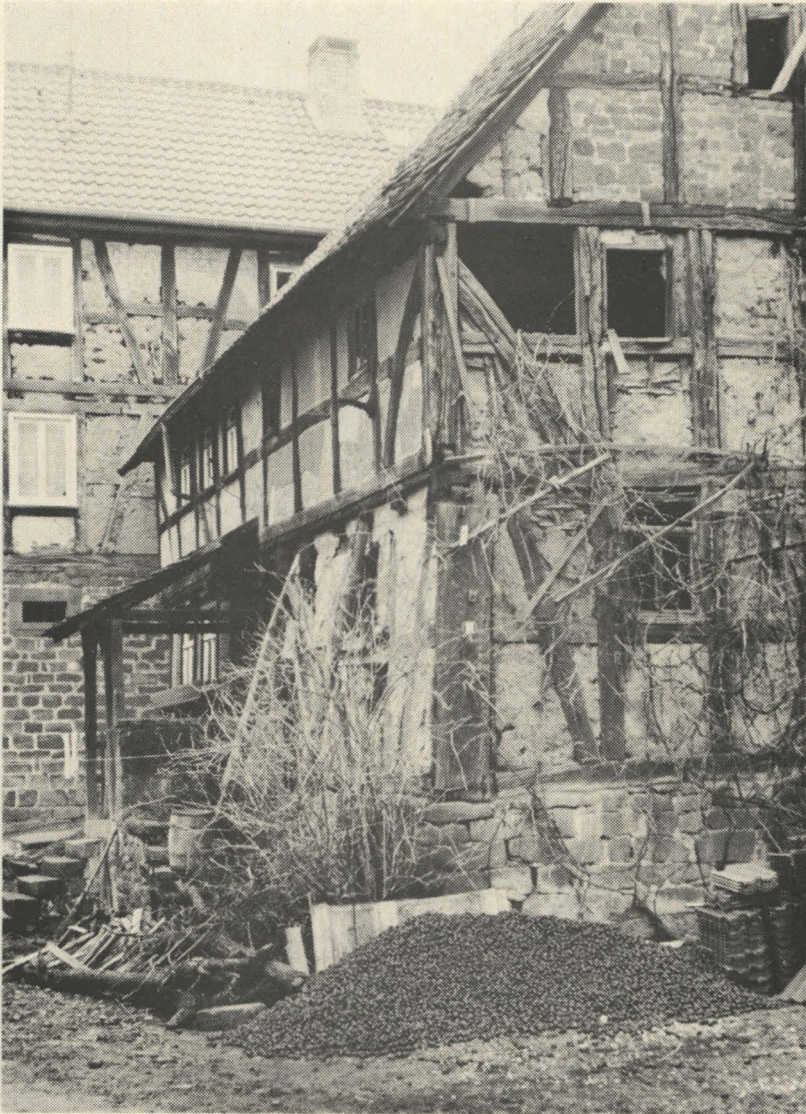
Haus im derzeitigen Zustand
