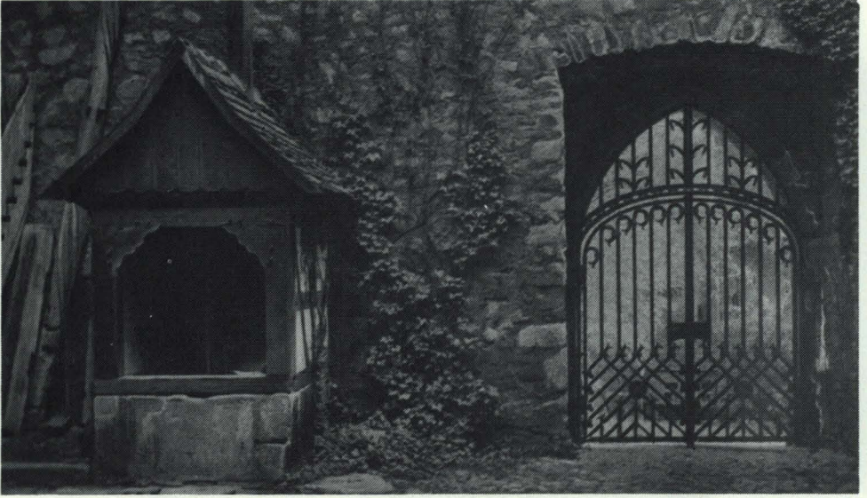
Schlosshof Brünnenhäuschen und das eiserne Tor zum Kanzleiberg
