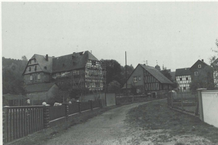
Ehemalige Wasserburg Elkerhausen von Nordwesten, Zustand Herbst 1982. Links die beiden Haupthäuser, rechts das ehemalige Torhaus mit Stallebau und Teile der Burgmauer (Foto Krupp)
