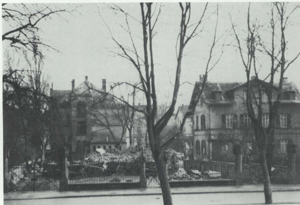
Die zerstörte Synagoge in der Südanlage
