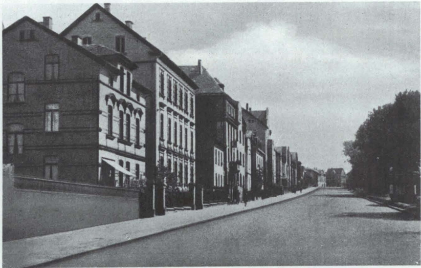
Bild 38: Licher Straße nach der Straßenverbreiterung 1938/ 39. Foto: Stadtbauamt
