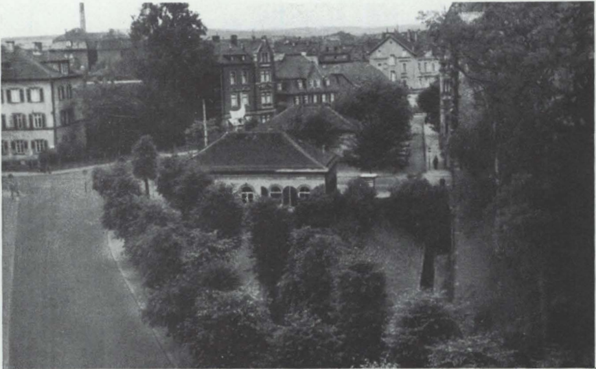
Bild 40: Selterstor vor dem Umbau in 1938; parallel zum rechten Bildrand sieht man den damals noch offenen Schoorgraben. Foto: Stadtbauamt
