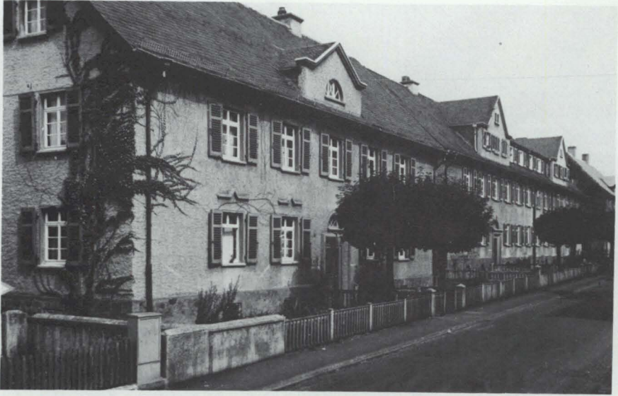
Bild 7: Am Kugelberg, Mietwohngebäude. Foto: Baugenossenschaft 1894
