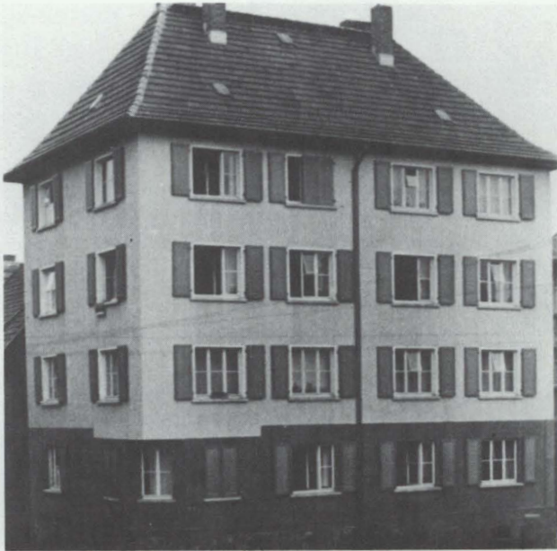
Bild 19: Wiederaufbau Alter Wetzlarer Weg, Eigentümer: Baugenossenschaft 1894 Gießen. Foto: W.Fischer
