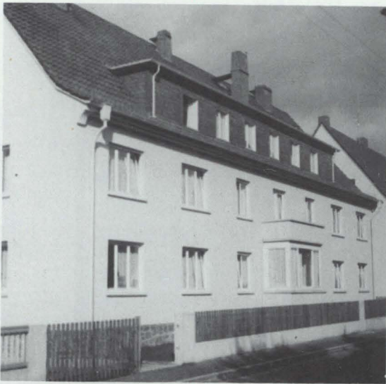
Bild 8: Am Kugelberg, Neubauten auf den Fundamenten der ehemaligen Reihenhäuser. Foto: Baugenossenschaft 1894
