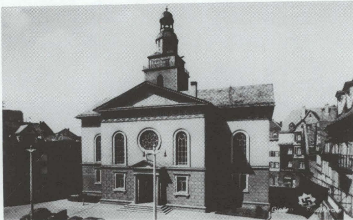
Abb.8: Die Stadtkirche vor der Zerstörung
