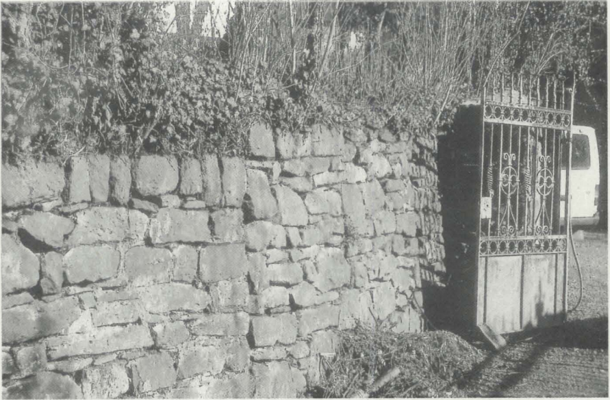
Abb. 5: Bruchsteinmauer und eisernes Hoftor am Hofeingang
