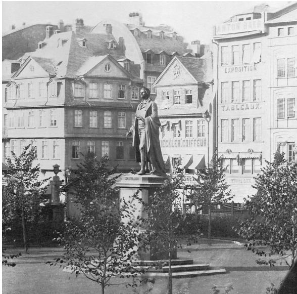
Abb. 2: Das Schillerdenkmal in Frankfurt nach seiner Umsetzung auf dem Schillerplatz (Repro)
