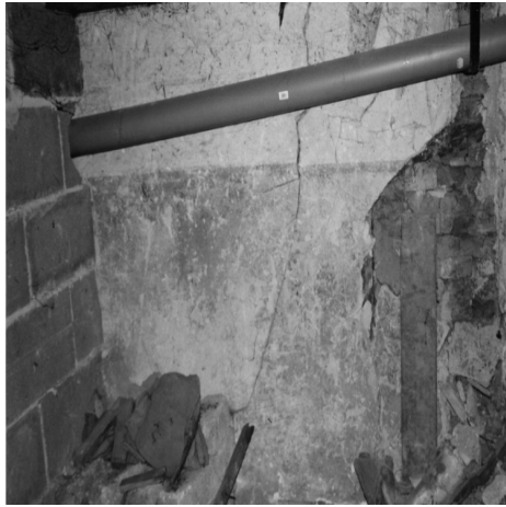
Abb. 5: Erdgeschoss S-Wand, Nov. 2003
