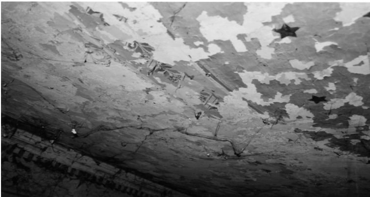
Abb. 8: Detail Decke, Nov. 2003
