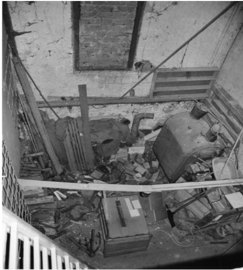
Abb. 4: Erdgeschoss, SO-Ecke, nach O, Nov. 2003
