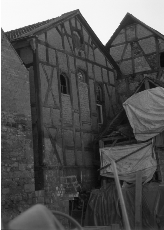
Abb. 1: Ostgiebel (heute umbaut und nicht mehr einsehbar) 1996
