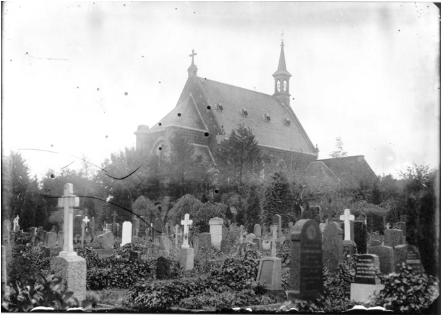
Ansicht Gräberfeld (Hochbauamt Stadt Gießen)
