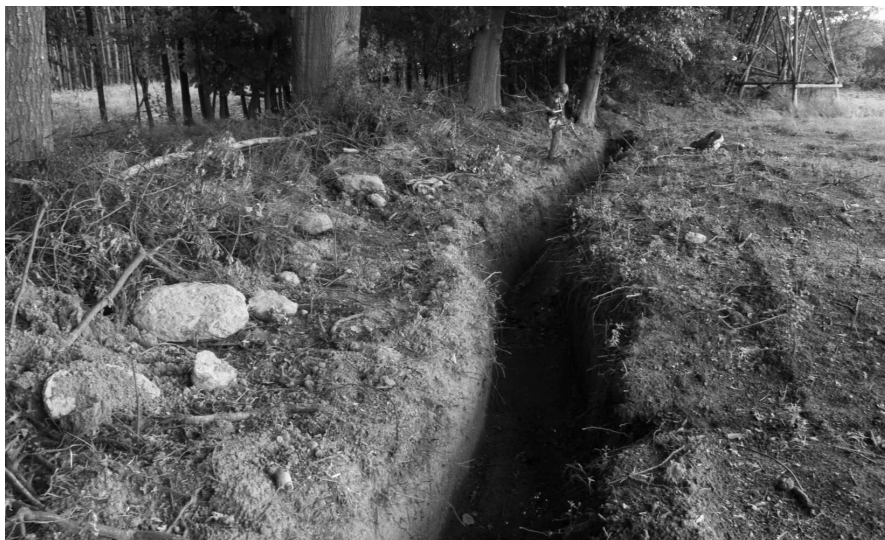
Abb. 2: Drainagegraben - Blick in Richtung S. Links zwischen Graben und Waldrand ausgeräumtes Basaltverwitterungsgeröll (16. Aug. 2008, Foto vb)
