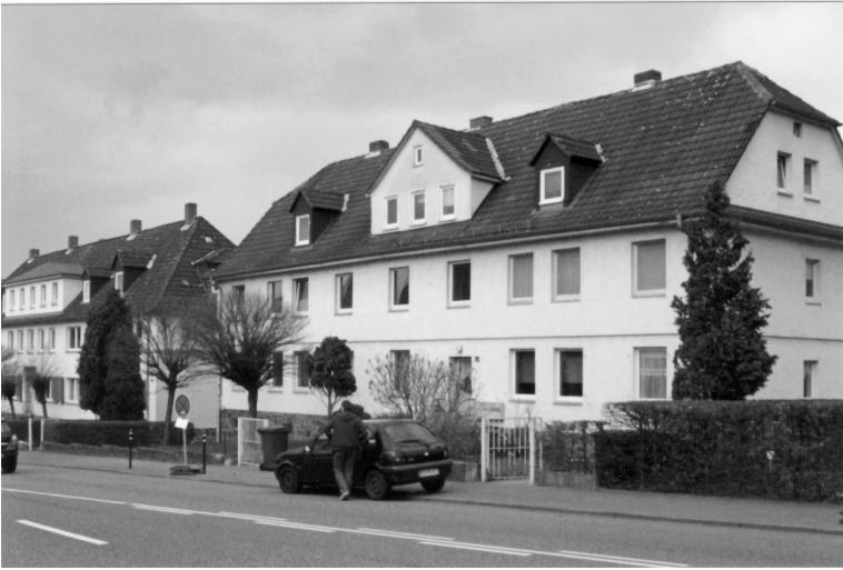
Kürzlich erworbene Häuser in der Grünberger Straße 65-77 für den Neubau
