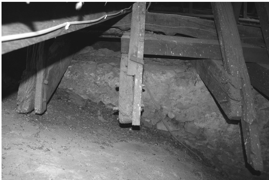
Abb. 7: Sparren-Dachbalken-Verbindung im NO
