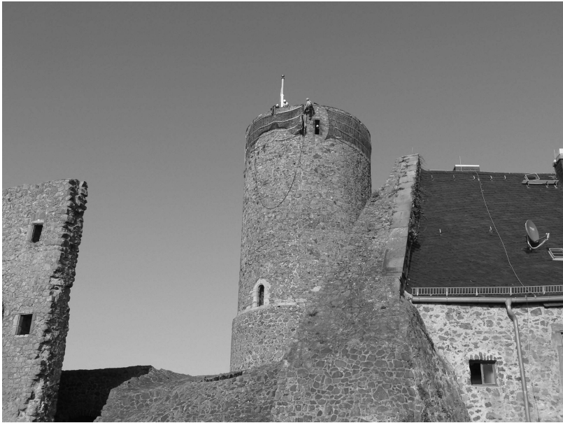
Anbringung einer Notsicherung am Bergfried im Herbst 2011; Foto: Margret Wagner
