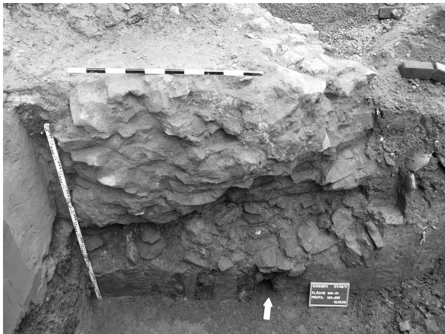
Abb. 2: Das massive Fundament des mittelalterlichen Stadttors, das über einer Gründung aus senkrecht in den feuchten Untergrund getriebenen Pappelpfählen (am unteren Bildrand) errichtet wurde.
