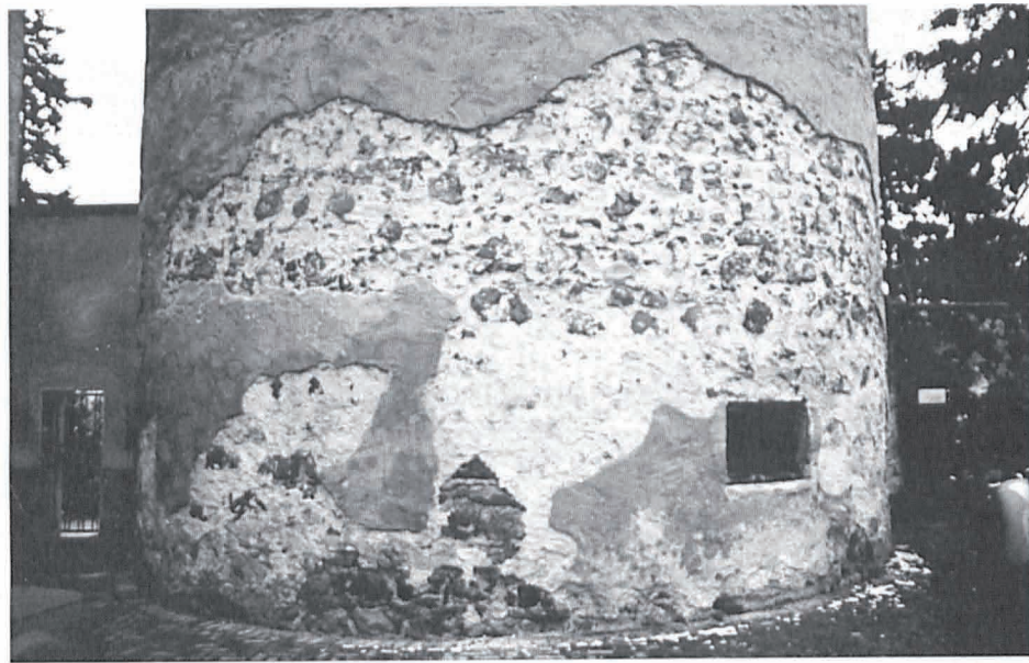
Abb. 1 und 2: Durch Salzkristallisation abgesprengter Putz am Roten Turm in Friedberg. Besonders deutlich sind die Schäden im Sockelbereich zu erkennen.
