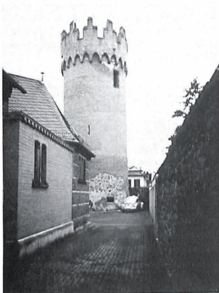
Abb. 1 und 2: Durch Salzkristallisation abgesprengter Putz am Roten Turm in Friedberg. Besonders deutlich sind die Schäden im Sockelbereich zu erkennen.
