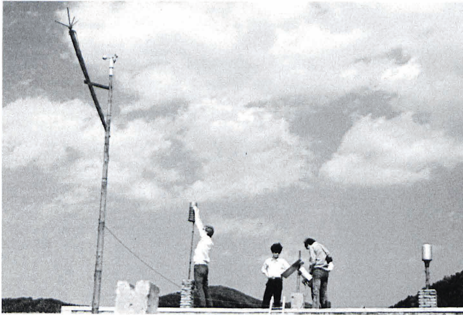
Abb. 7: Aufbau der Klimameßstation Huzhou auf dem Dach einer Forststation.
