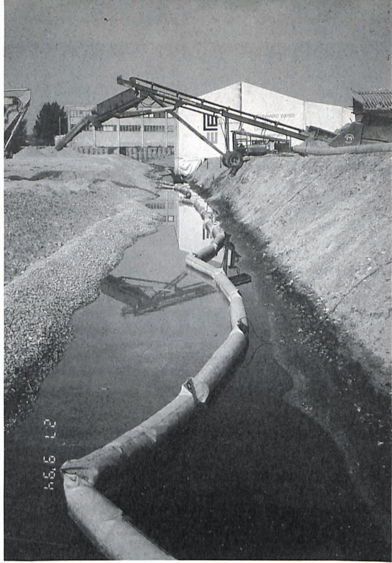
Abbildung 1: Ansicht auf die Aushubarbeiten im Rahmen der on-site Sanierung des Altölschadensfalls Pintsch Hanau. Die Auffüllung ist abgetragen und der Grundwasserspiegel freigelegt (Bildmitte). Rechts von der Querkontaminationssperre befindet sich der kontaminierte Bereich, links der sanierte.
