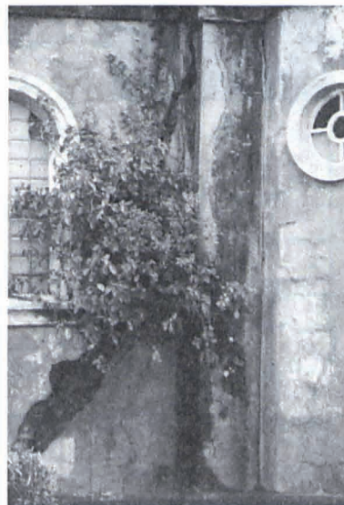
Abbildung 5: Schäden an der Kirche der Stadt Puriscal (Rutschung Puriscal)
