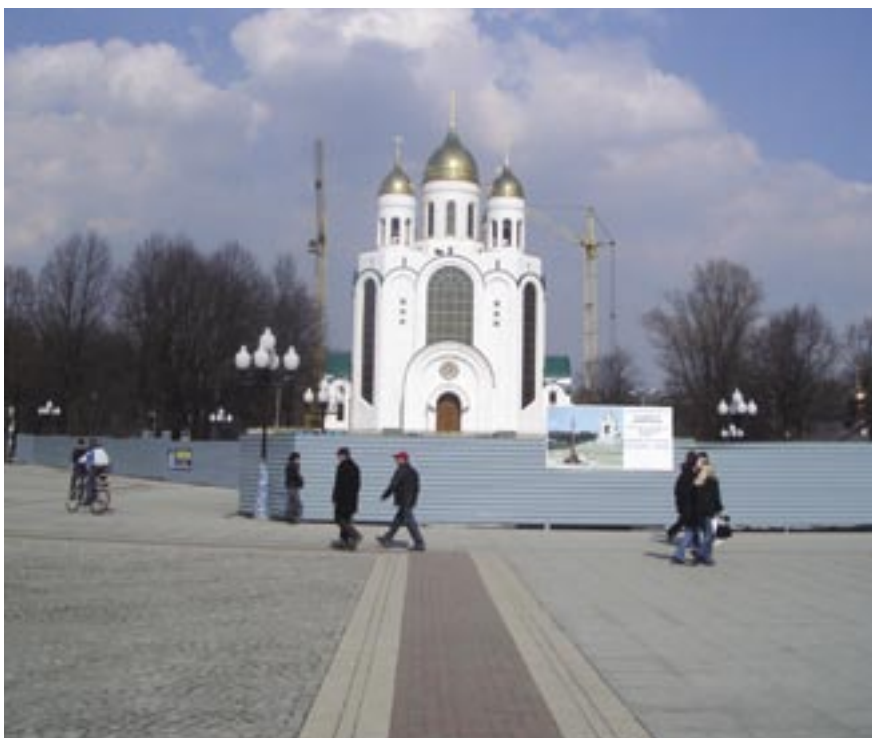
Die Kathedrale mit der Baustelle für die geplante Siegestsäule im April 2006.
