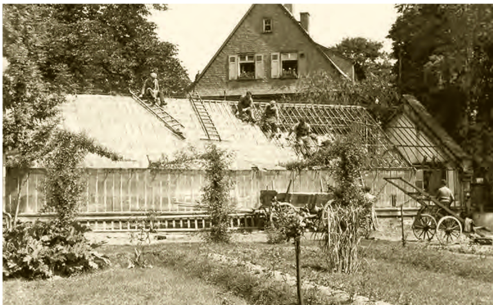
Abb. 4: 1934 musste das ehemalige Gewächshaus von Hermann Hoffmann abgerissen werden.
