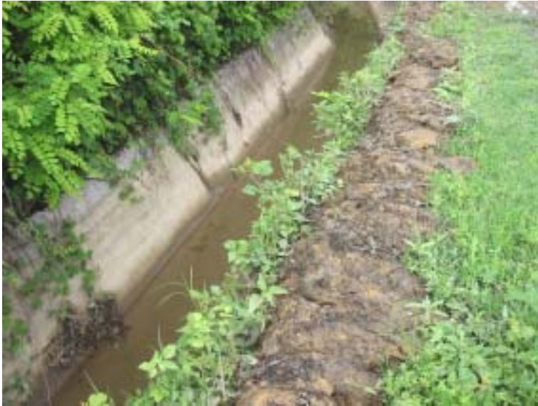
Abb. 17: Ausgehobene Sedimentschlämme am Rande des Kanals.
