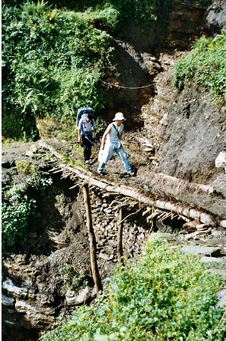
Foto 5: Instandsetzung des durch die Rutschung bei Komrondada zerstörten Weges durch den Bau einer behelfsmäßigen Brücke und durch den Versuch, die Rutschung mit Hilfe einer Steinmauer zu stabilisieren (Aufnahme: M. LÖBNER & C. SCHMELZ).
