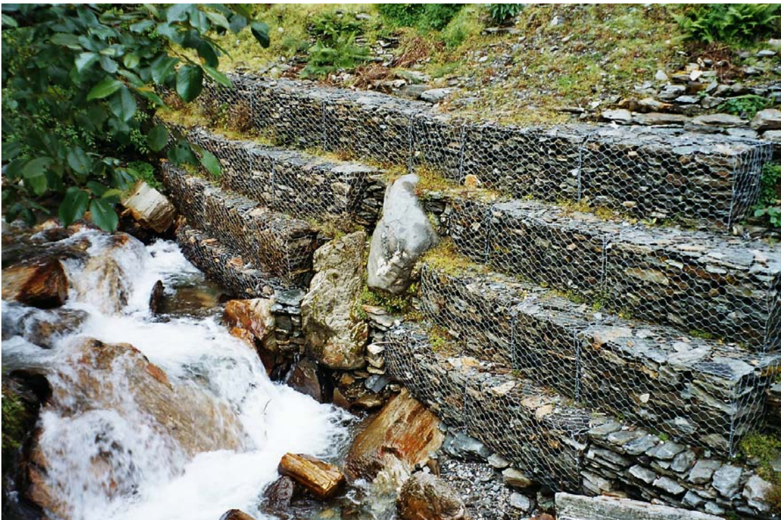
Foto 6: Massive Stabilisierung einer Uferböschung mit Gabion Boxes neben der Brücke über den Ghatte Khola bei Ghandruk. Nur so ist auf längere Sicht das Brückenfundament zu stabilisieren (Aufnahme: M. LÖBNER & C. SCHMELZ).
