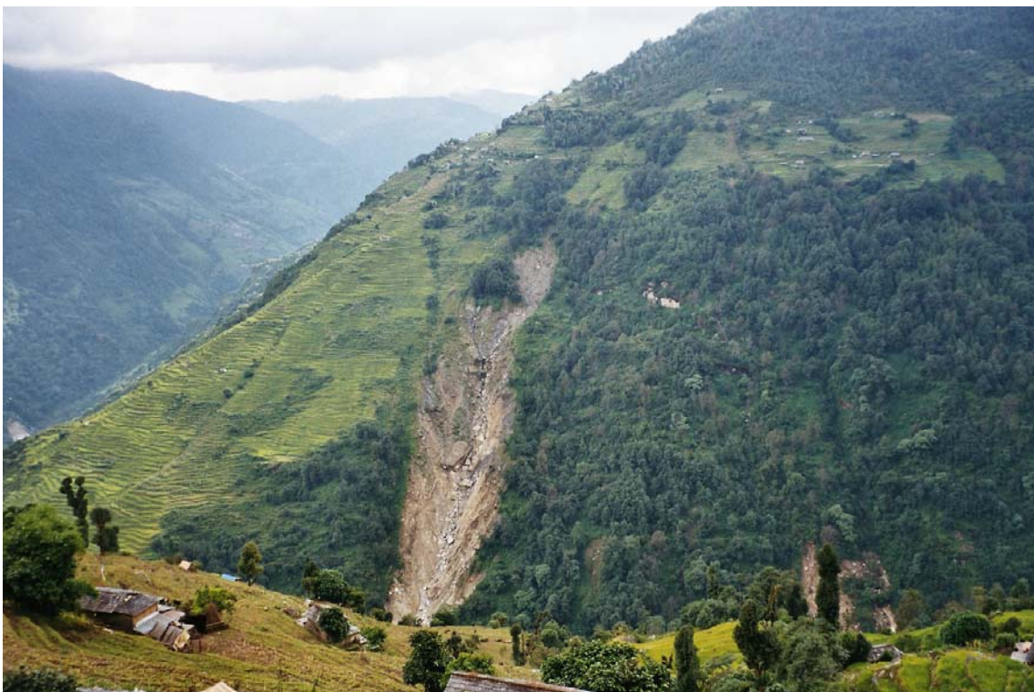
Foto 2: Große Rutschung am Nordhang des Kimron Khola Tals. Oberhalb der Rutschung liegt der Ort Uri, dessen Schule wegen Rutschungsgefahr verlagert werden musste. Die noch aktive Rutschung ist nach Aussagen der Anwohner vier Jahre alt und hat bari -Terrassen zerstört. Der geologisch instabile westliche Teil des Hanges ist zumeist von Wald bewachsen, da die Lokalbevölkerung die Gefahr einer Kultivierung dieses Hanges erkannt hat (Aufnahme: M. LÖBNER & C. SCHMELZ).
