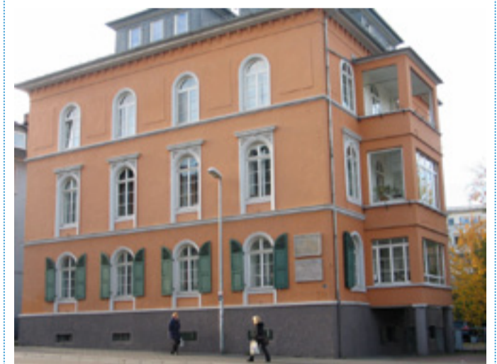
Das Gebäude Frankfurter Straße 10 mitsamt Hinterhaus hat den Krieg überlebt und ist einer der wenigen authentischen Orte universitären Lebens in Gießen.
