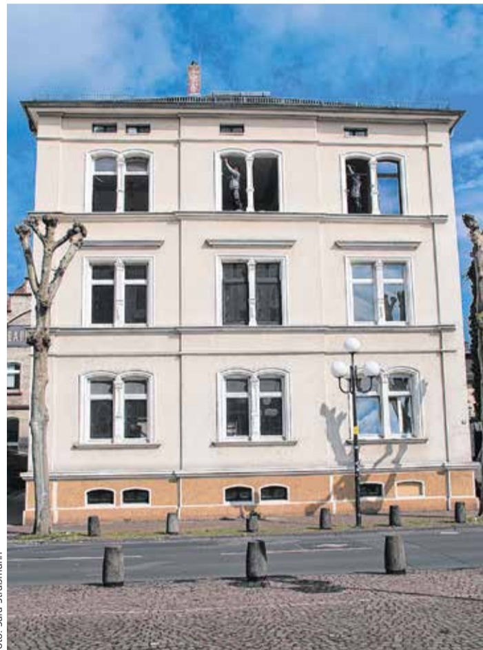
Ludwigstraße Nr. 28 – noch wird hier fleißig renoviert.
