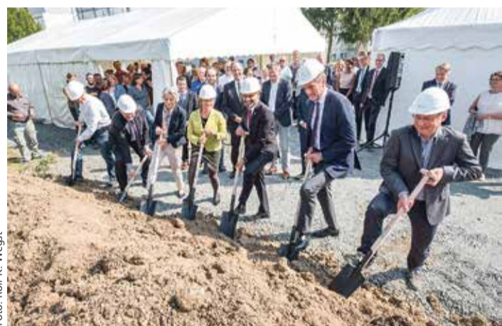
Spatenstich für die neue Pflanzenforschungsanlage.
