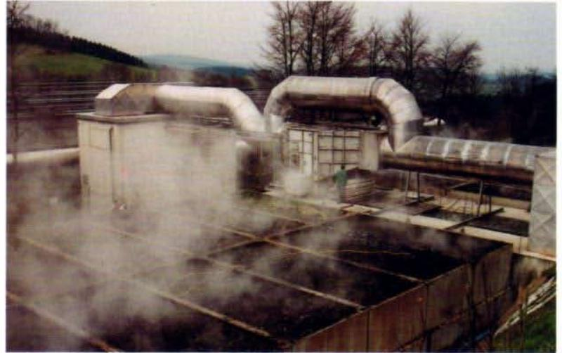
Abb. 6: Biofilter, bestehend aus Wurzelholz, Rindenmulch und Kompost, reduziert geruchsintensive Stoffe, Schadstoffe, organische Partikel und Mikroorganismen in der Abluft.
