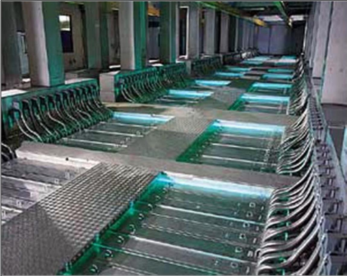
**Abb. 21:** System zur Trinkwasseraufbereitung in Manukau, Neuseeland, Wasserfluss: 50.400 m<sup>3</sup>/h, UV-Leistung: mind. ~320 kW, Anzahl UV-Strahler: ~2.500
