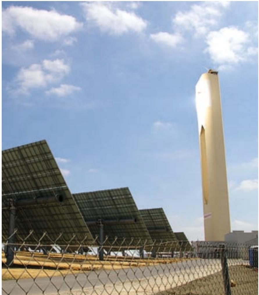
Abb. 2: Solarturmkraftwerk PS10 bei Sanlúcar la Mayor, westlich von Sevilla. 120 Spiegel fokussieren Sonnenlicht auf einen 115 m hohen Turm. So werden 6.000 Haushalte mit Elektrizität versorgt.
