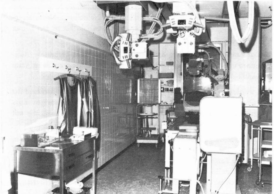
Abb. 4: Unter beengten Verhältnissen arbeitet die Neuroradiologie in diesem Raum an Untersuchungseinheiten für Angiographie, für Enzephalographie, Myelographie und Tomographie.
