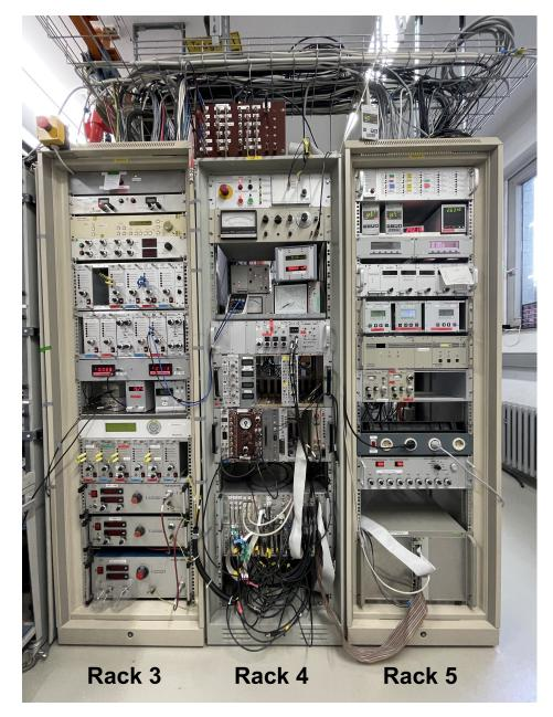
Abbildung 2.6 – Rack 3 (links), Rack 4 (Mitte) und Rack 5 (rechts). Rack 3 und 4: Versorgung der ionenoptischen Elemente, Magnete und der Ionenquelle sowie die Steuerung der Hubmechanik der Elektronenkanone. Data-Routing in Rack 4 unten. Rack 5: Sicherheitsrelevante Systeme wie die Druck- und Kühlwasserüberwachung sowie die Überstrom-Abschaltautomatik der Elektronenkanone. Der Rechner für das Control-Routing ist unten zu sehen.
