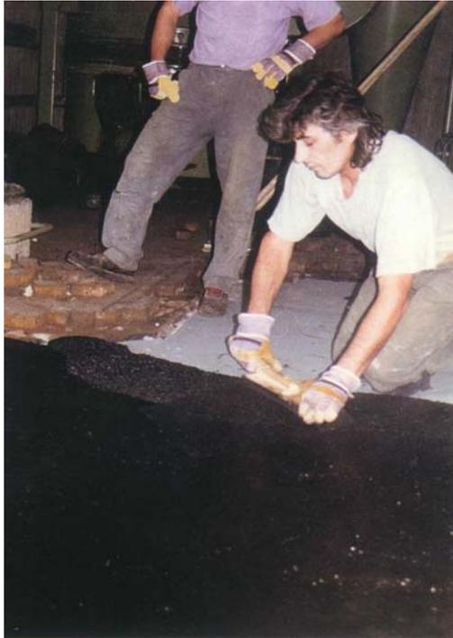
**Abbildung 1.4:** Streicher beim manuellen Einbau von Gussasphalt in einem Innenraum
