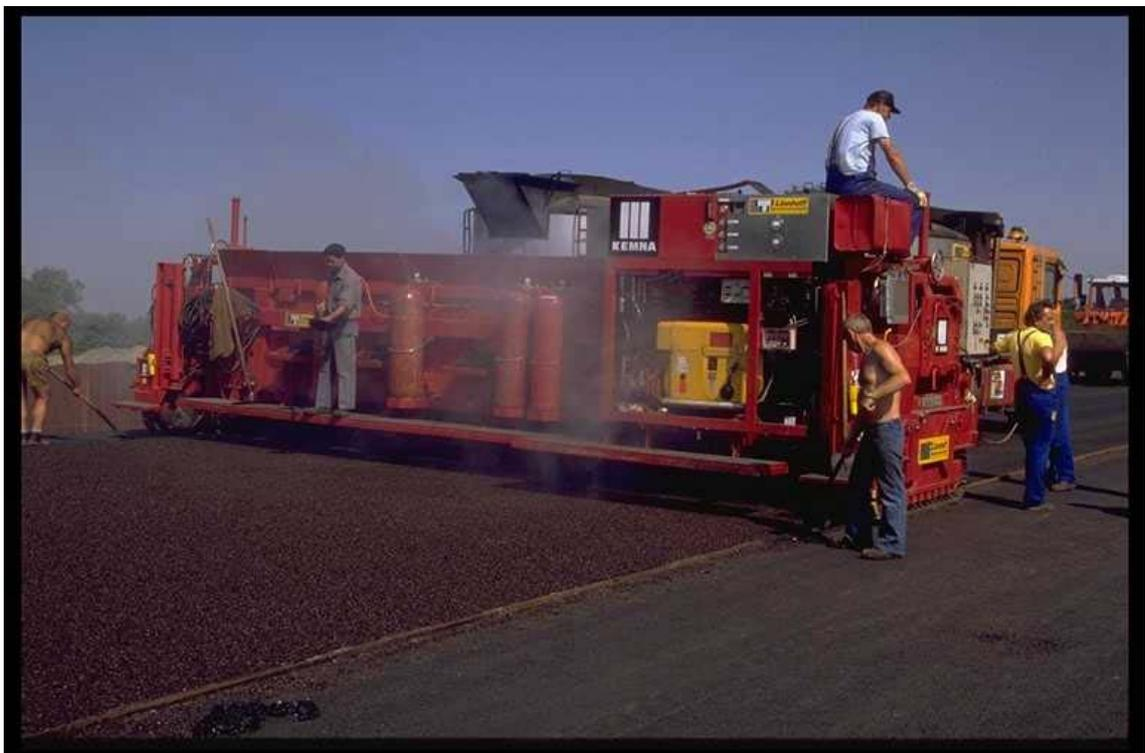
**Abbildung 1.2:** Einbau von Walzasphalt im Straßenbau
