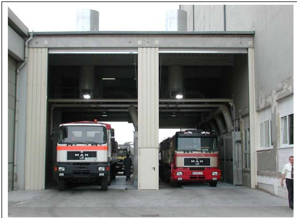
**Abbildung 6-4: Getreideannahme mit zwei Gossen und Entstaubungsanlage**
