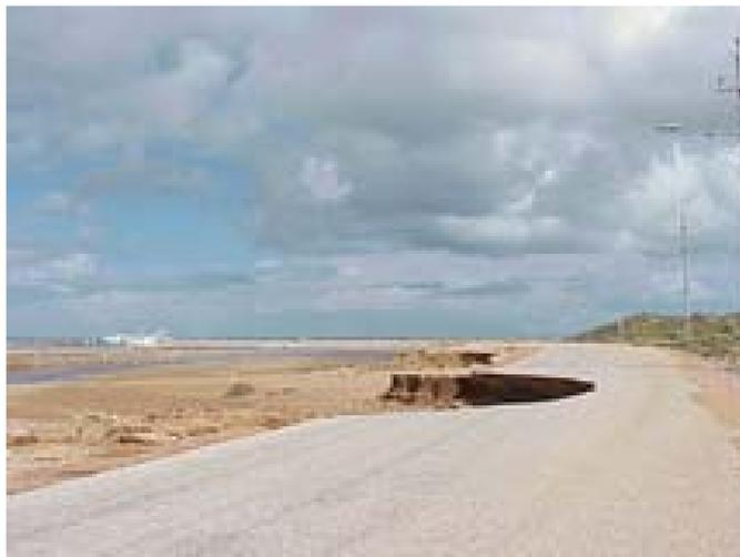
**Abbildung 2:** Durch eine Storm Surge verursachte Erosion an einer Küstenstrasse in Exmouth Australien. Auslöser war der Tropische Wirbelsturm Vance 1999. (Quelle: Bilderarchiv des australischen Wetterdienstes, 2004)
