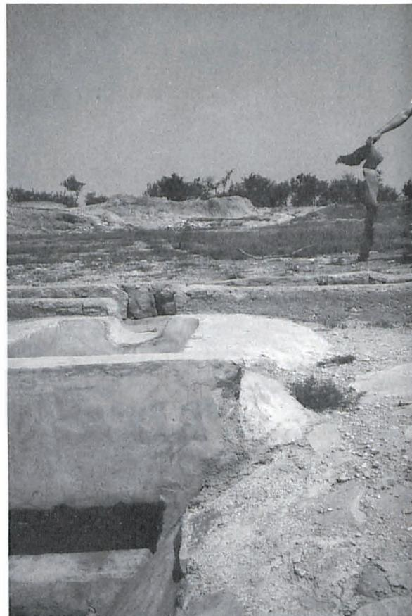
Bild 9: Vorrichtungen aus Beton und Kunststoffabdichtung zum Schutz der Grotten vor Niederschlägen (Foto: Strübel)
